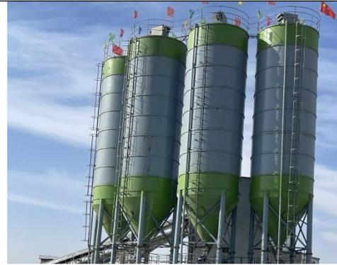
封闭廊道+仓顶除尘器
